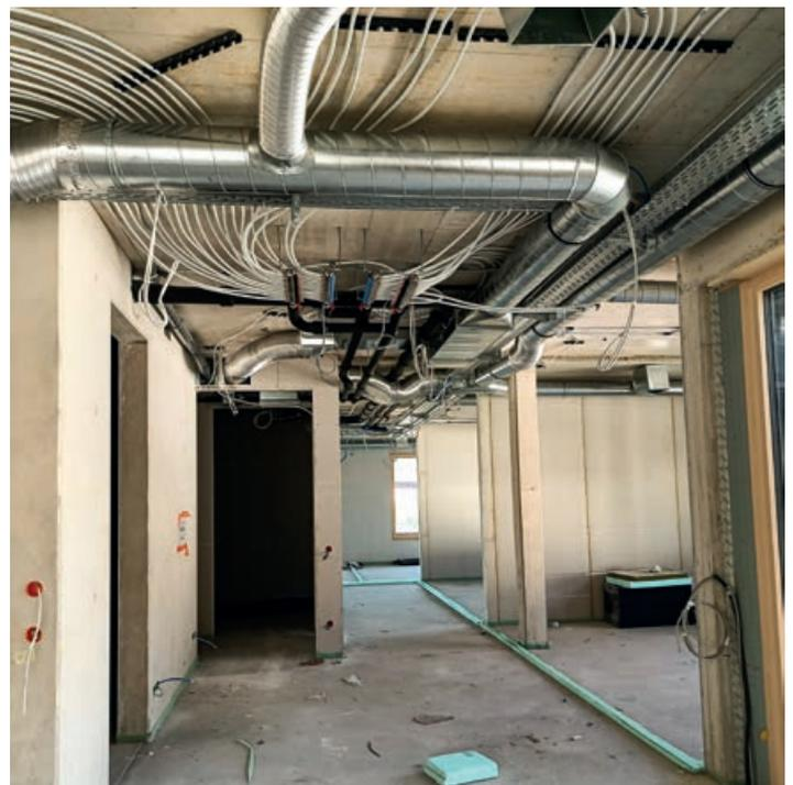
Ein Blick hinter die abgehängte Decke. Lüftungsrohre, Heiz- und Kühlrohre sind die vorherrschenden Elemente in der abgehängten Decke.
