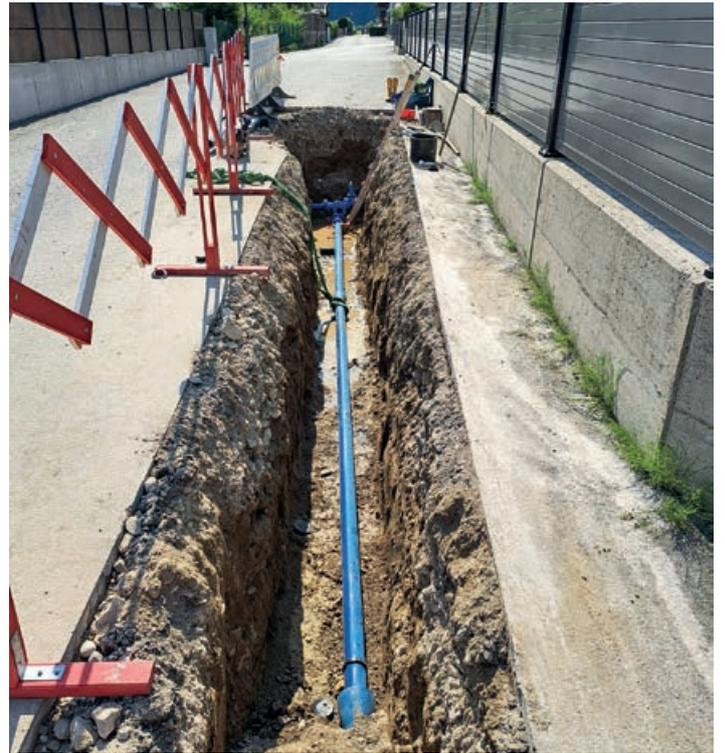
Die neu verlegte Gusswasserleitung soll wieder 60 Jahre lang zuverlässig Wasser zu den Haushalten transportieren.
