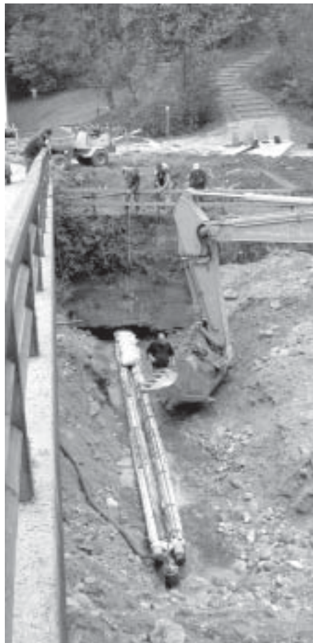
Die Erdgasleitung quert parallel zur Brücke den Sparchenbach.
