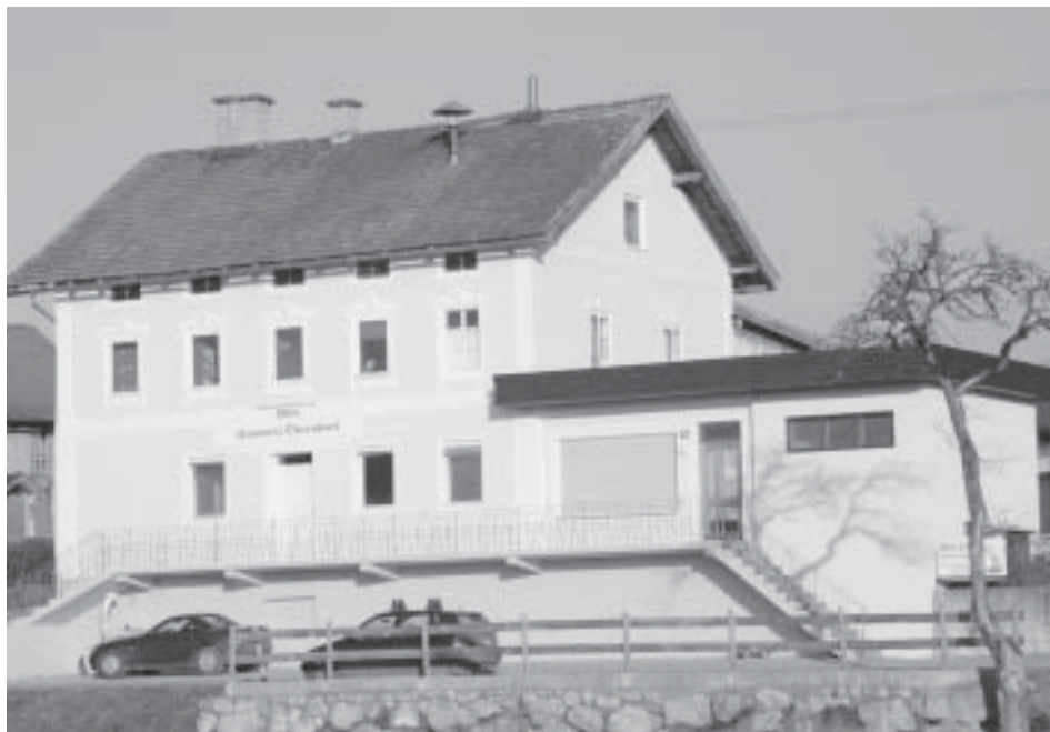
Die Oberndorfer Sennerei, ein Gebäude mit einer 100-jährigen Tradition, wurde heuer außen saniert und ist somit auch für die Zukunft gerüstet.
