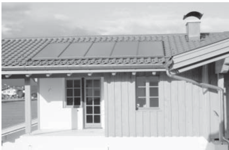
Mustergültig in die Dachhaut integrierte Solaranlagen stören das Ortsbild nicht.
