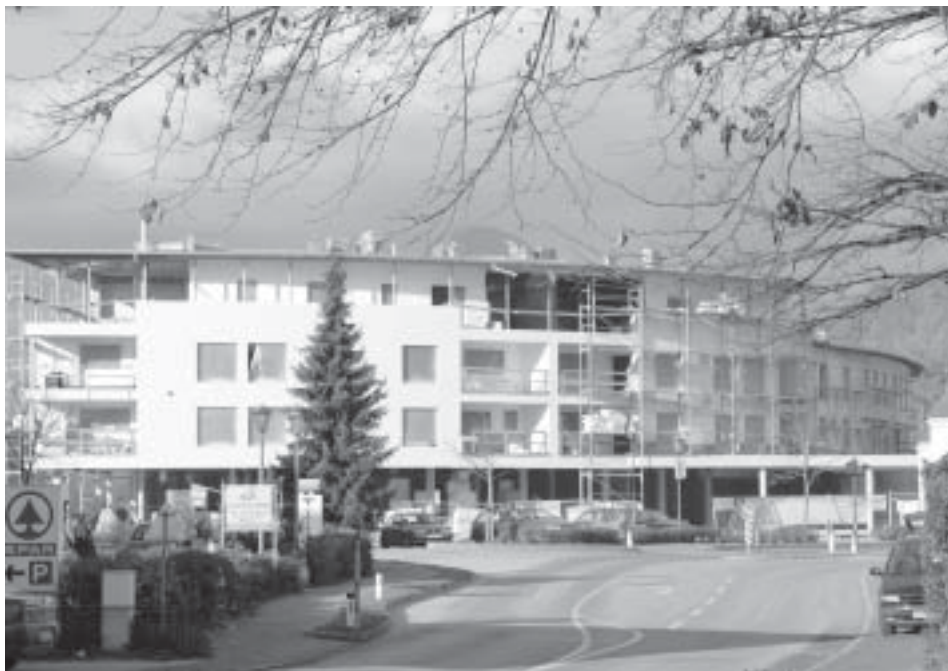
In der Zielgeraden – das neue Wohn- und Geschäftshaus am Dorfplatz wird demnächst fertig.
