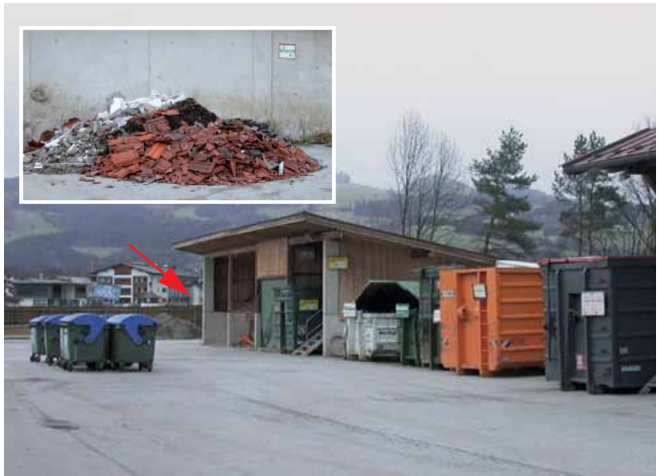
Die Sammelstelle für Bauschutt im Recyclinghof hinter den Lagerhallen auf der rechten Seite.
